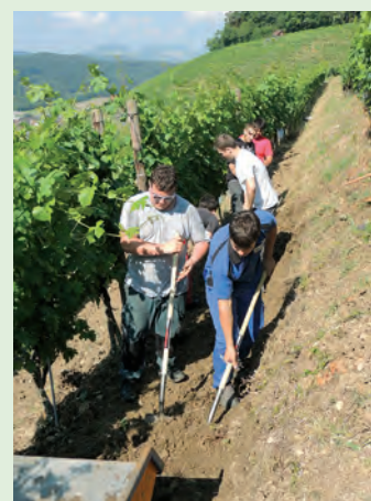
Birmenstorf Sanierung Rebbergterrassen
